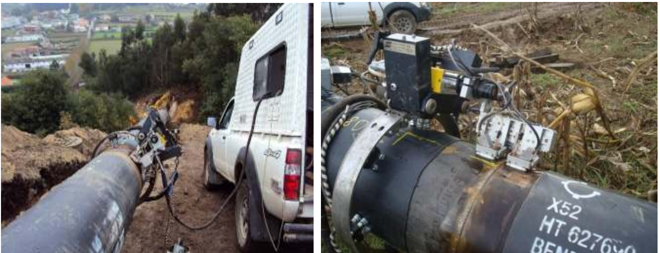
شکل ۱ استفاده از سیستم بازرسی آلتراسونیک اتوماتیک Phased Array برای بازرسی جوش خطوط لوله به جای رادیوگرافی (شرکت ISQ پرتقال)
